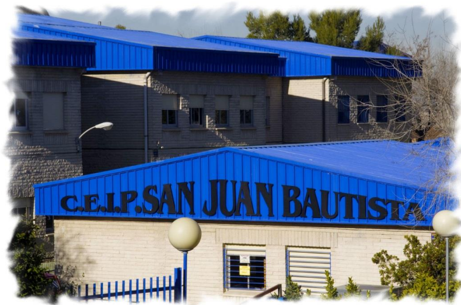
Imagen de las antiguas instalaciones del centro, destacando el marcado color azul de sus tejados.
